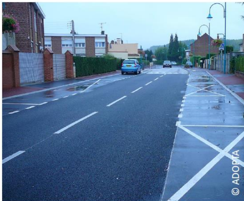
Voirie en enrobé poreux
