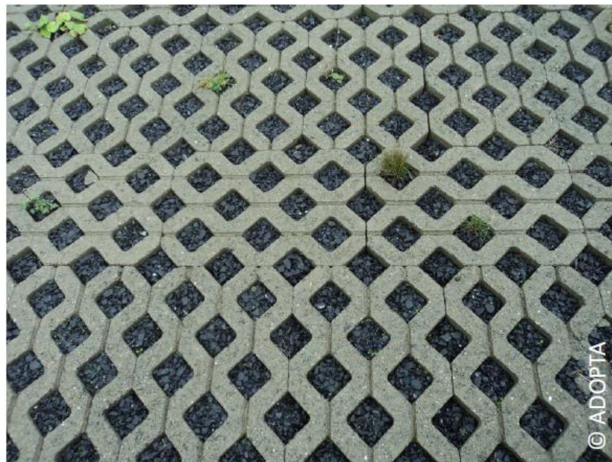
Zone de stationnement en dalle béton alvéolé
