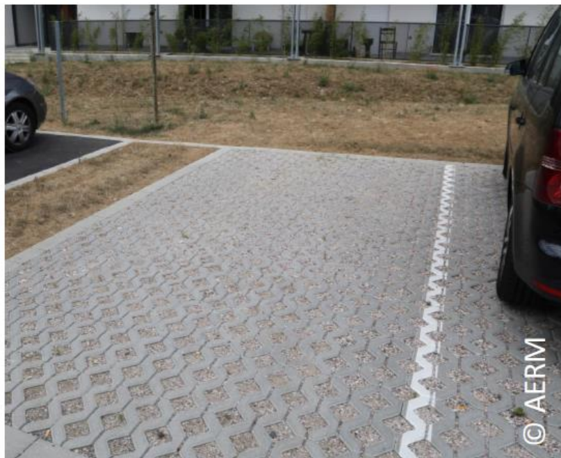
Zone de stationnement en dalle béton alvéolé
